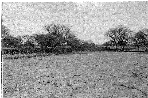
Photo 12 Le barrage est prolongé par des ailes en pierres qui barrent tout le bas-fond et jouent le rôle de digues filtrantes.
