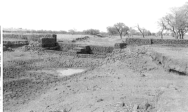
Photo 10 Le barrage est bien ancré dans les berges.
