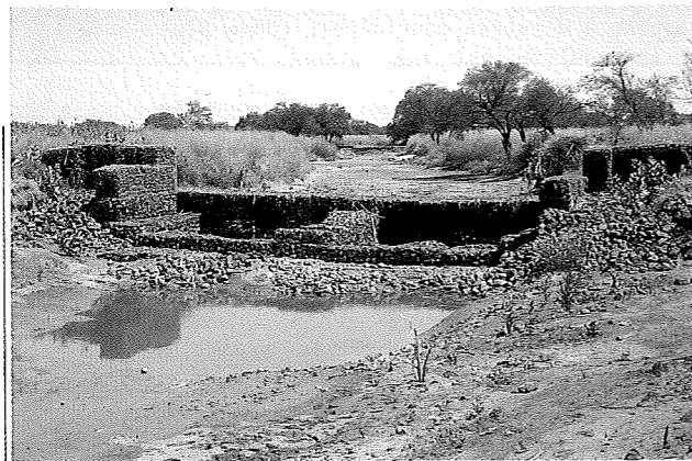
Photo 11 Le seuil est suffisamment large pour laisser passer le flot des grosses crues amorti par le bassin d'amortissement et de dispersion.
