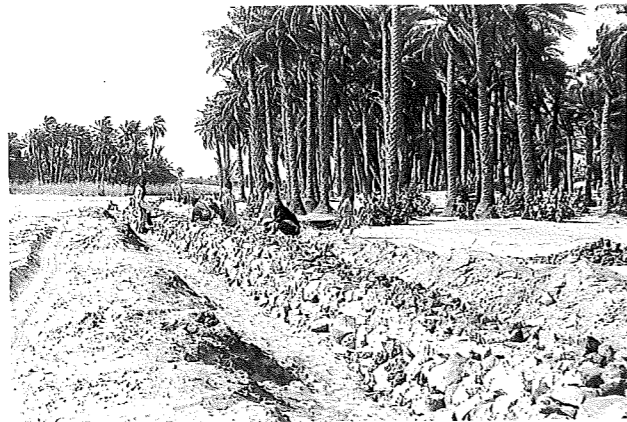
Photo 6 Digue longitudinale de berge construite dans l'oued d'IN GALL par le Génie Rural.
