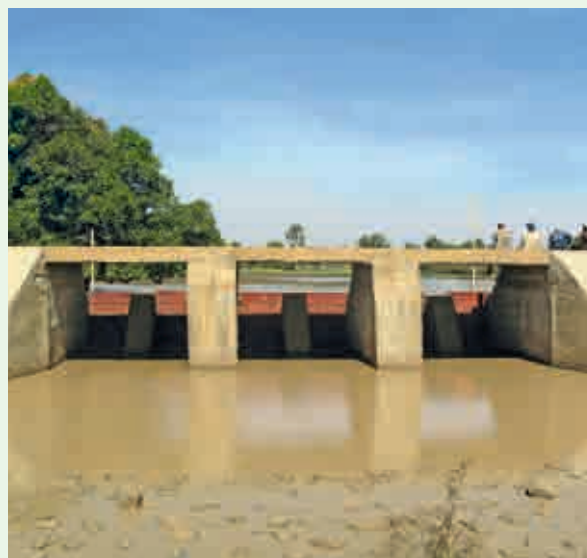
Petit barrage construit au Mali avec le soutien de la coopération allemande
