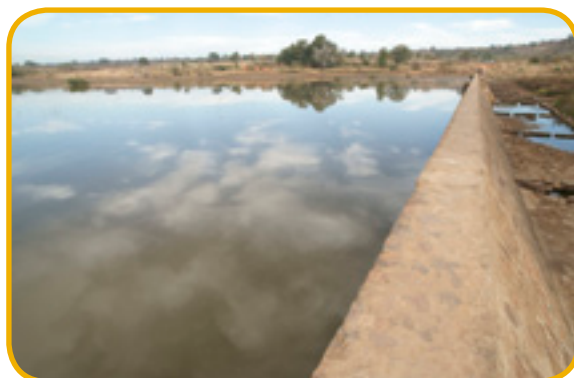
Photo 20 : micro-barrage en béton cyclopéen de Sounikéyni
