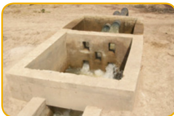
Photo 11: prise de canal secondaire sur canal principal
