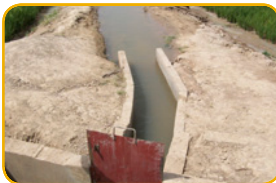
Photo 11: prise de canal secondaire sur canal principal
