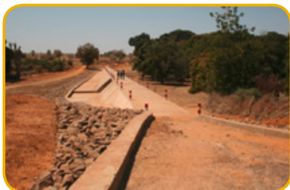
Photo 19 : pont-barrage de Tiembougou en béton cyclopéen
