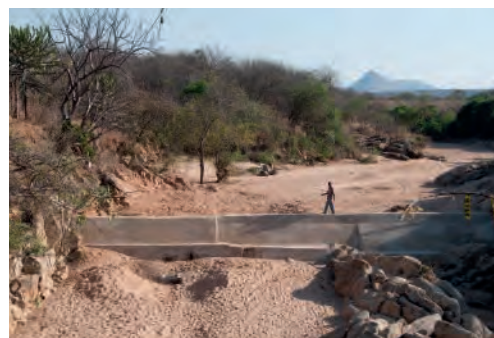
Sand dam Embu, Kenya. (HP. Liniger)
