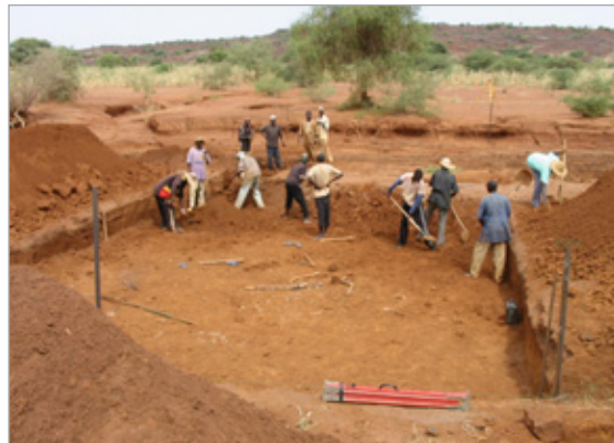
Illustration 7: Chantier école pour la formation d'artisans locaux. Source: Lütjen
