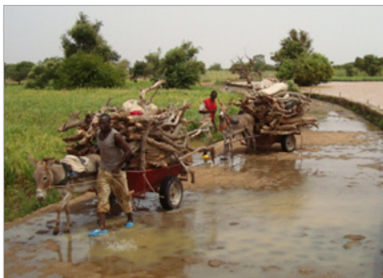
Illustration 3: Un seuil d'épandage conçu comme gué pour traverser la vallée. Source : Bender (2011), p. 16
