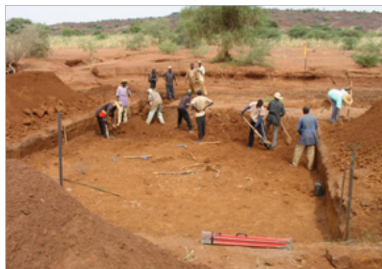
Abbildung 7: Schulbaustelle zur Ausbildung lokaler Handwerker. Quelle: Lütjen
