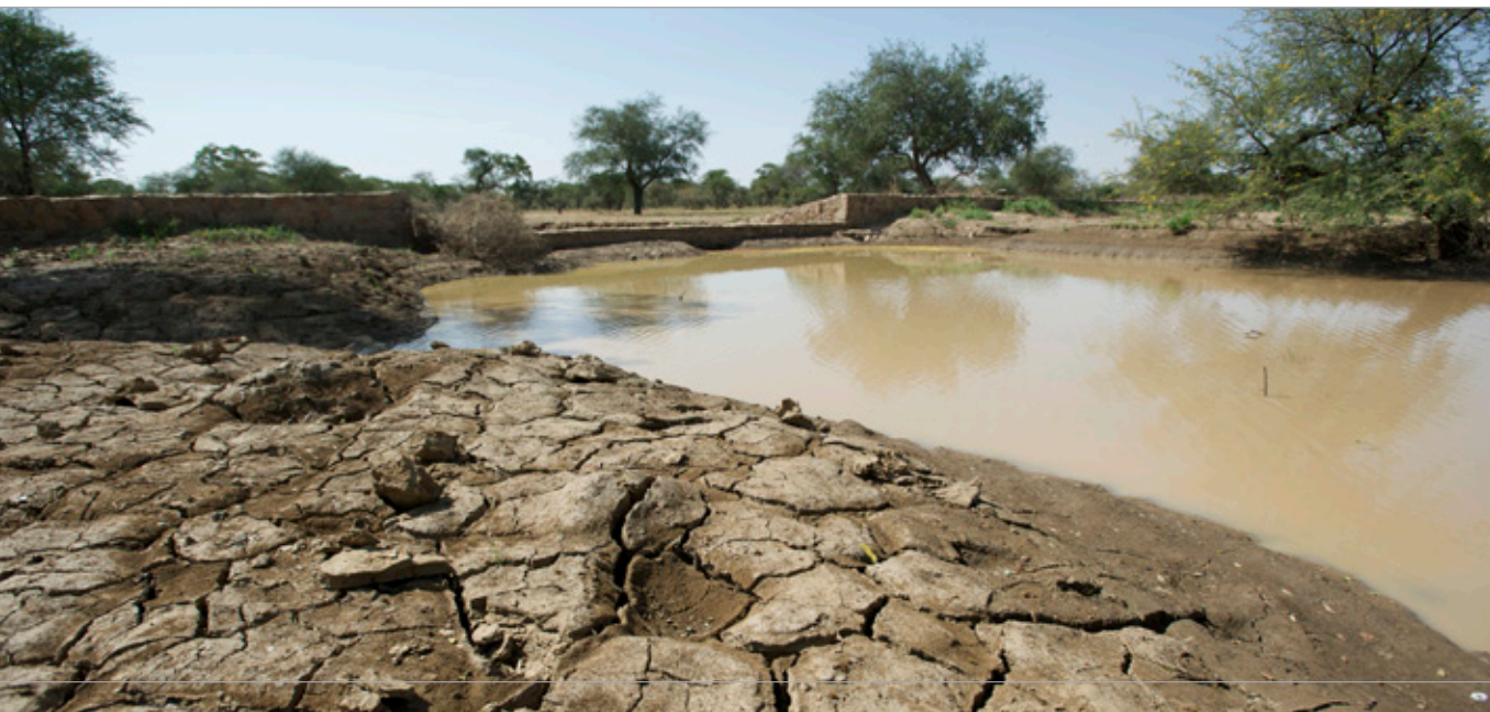
Le seuil d'épandage facilite l'approvisionnement en eau et fait augmenter la fertilité du sol © GIZ / Klaus Wohlmann
