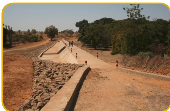
Photo 20 : micro-barrage en béton cyclopéen de Sounikényni
