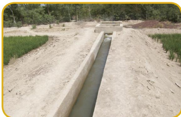
Photo 11: prise de canal secondaire sur canal principal
