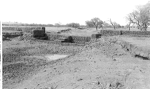
Photo 10 Le barrage est bien ancré dans les berges.
