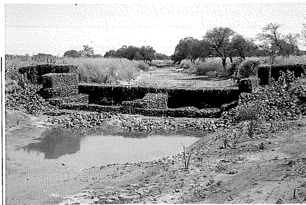
Photo 11 Le seuil est suffisamment large pour laisser passer le flot des grosses crues amorti par le bassin d'amortissement et de dispersion.
